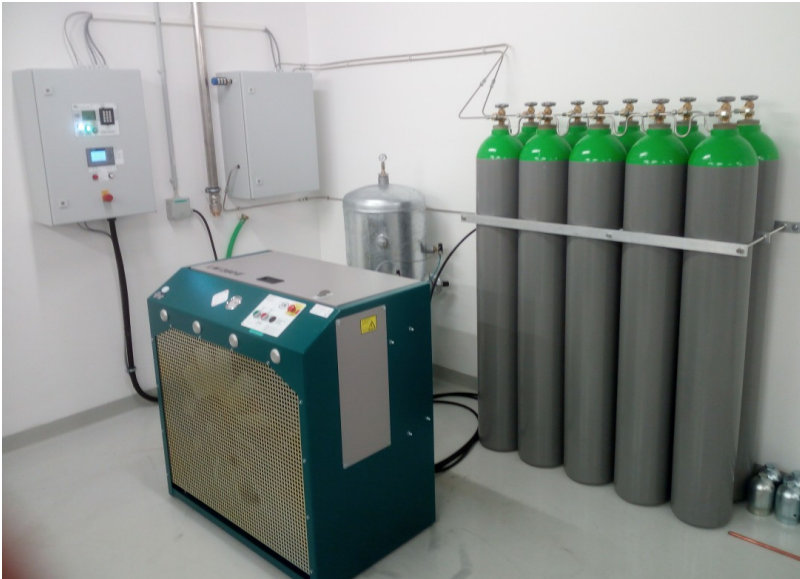
wairXpres-Anlage, Baujahr 2006 Maximaldruck 300 bar
